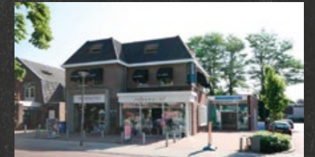
STATIONSLAAN 31A • NUNSPEET Nabij het centrum, met voldoende parkeergelegenheid bieden wij u aan deze KANTOORRUIMTE van ca. 200m².
